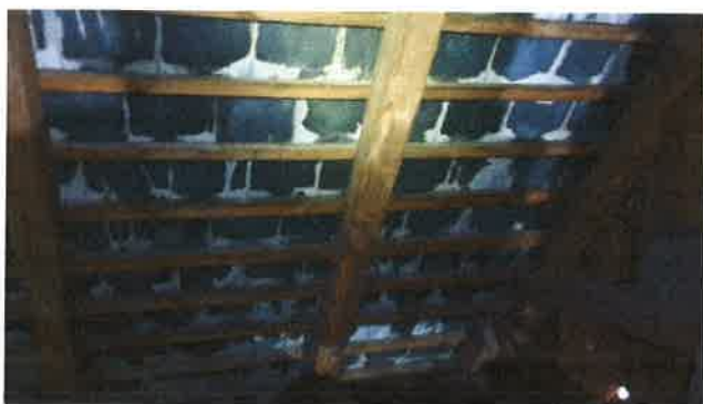
Widok od spodu płytek łupka mocowanych na łatach.
