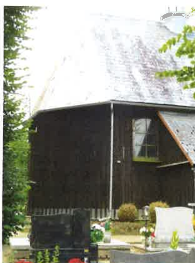
Północna i tylna połać dachu.
