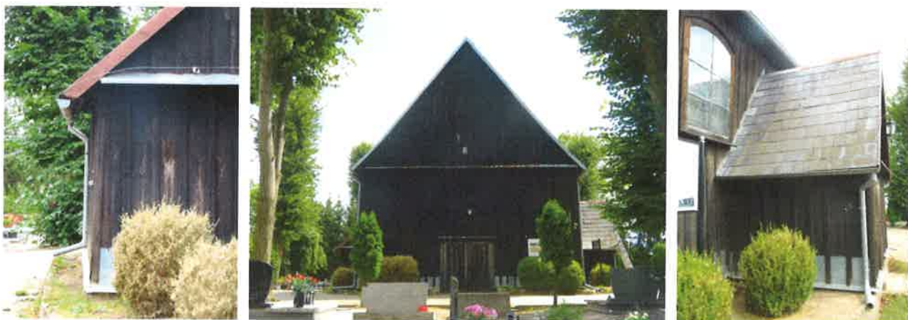
Widok dachu z opierzeniem nad zakrystią, nad połaciami głównymi oraz widok połaci zachodniej kruchty.
