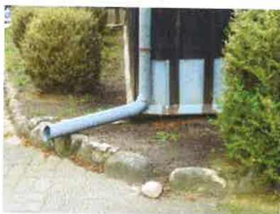
Wylewka rury spustowej.
