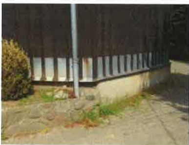
Ujście wody do studzienki.
