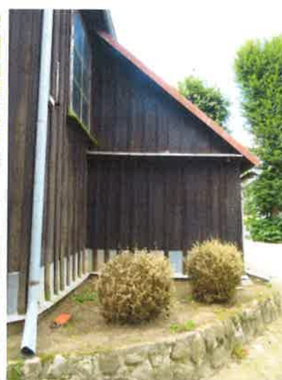
Widok krawędzi dachu zakrystii.
