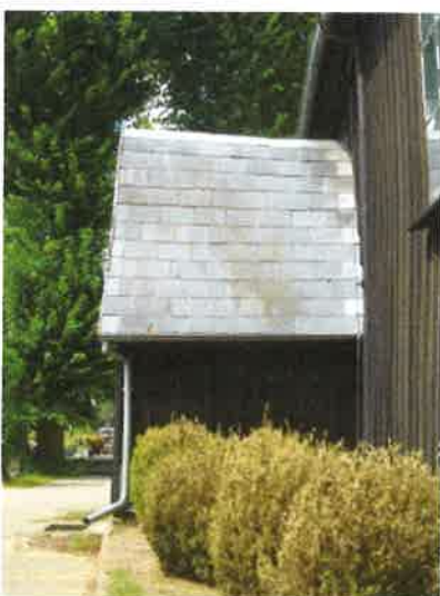
Dachu nad kruchtą od wschodu.
